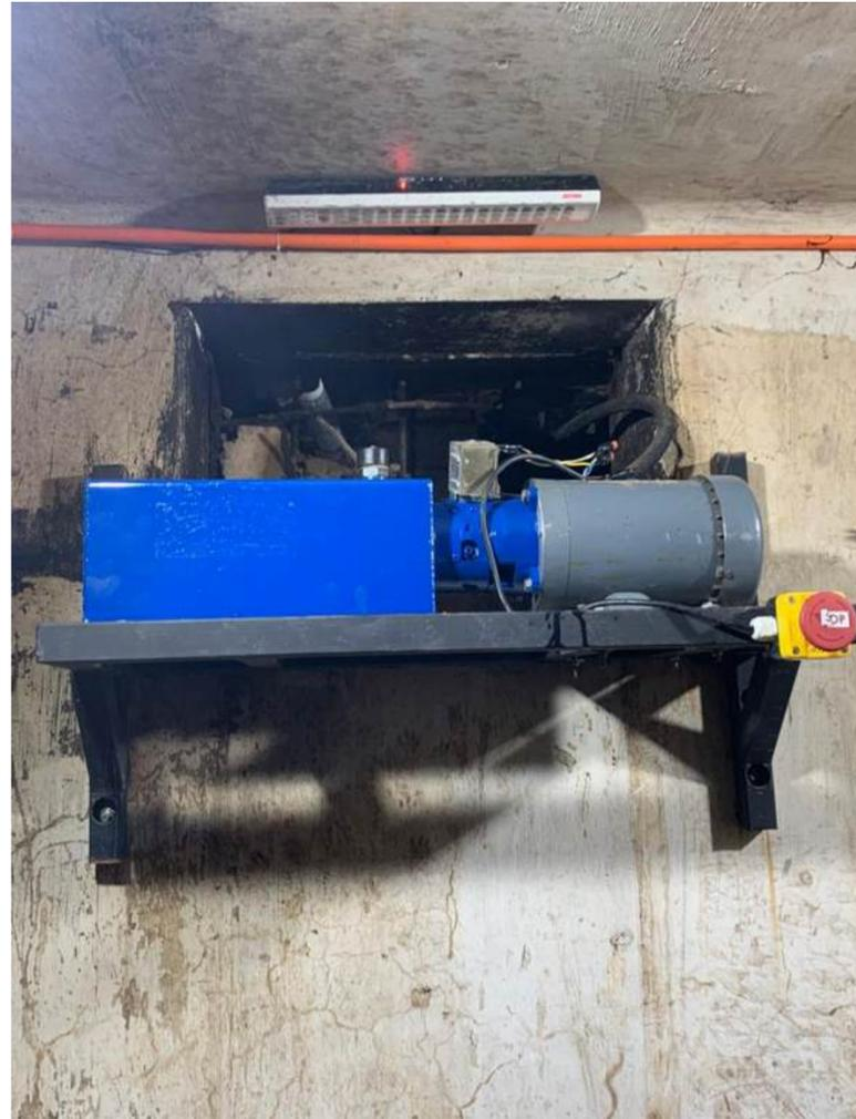
Reparación de motor y reposición de bomba hidráulica de accionamiento del montacargas.
